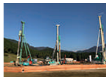
機械攪拌機での施工
