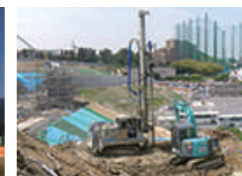
機械攪拌機での施工
