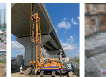
機械攪拌機での施工
